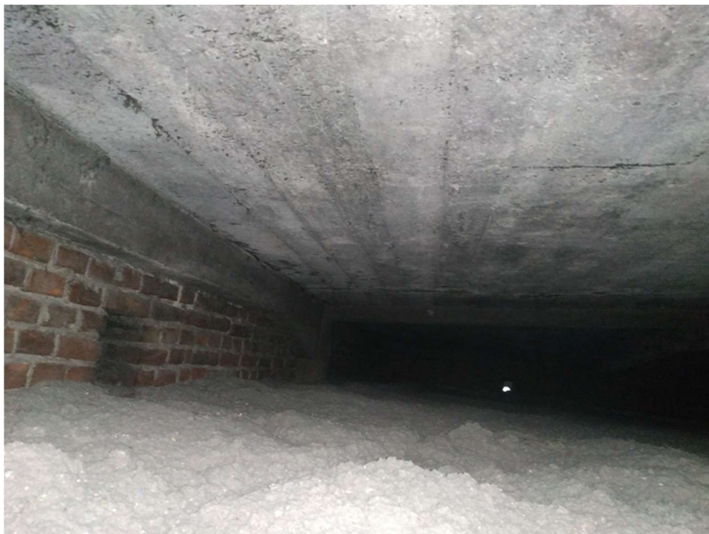
Zdjęcie 5 – stropodach żelbetowy
