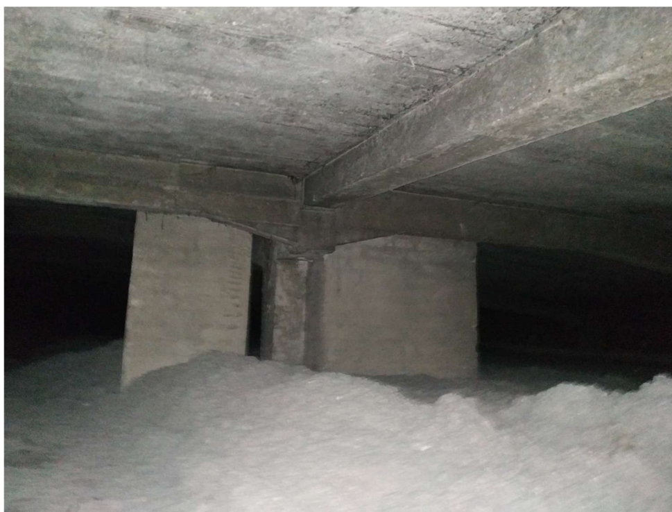
Zdjęcie 6 – stropodach żelbetowy
