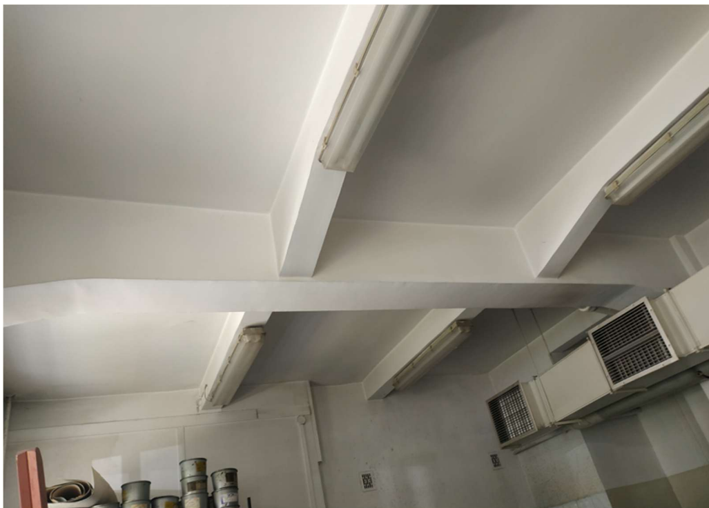
Zdjęcie 3 – strop płytowo-żebrowy nad parterem
